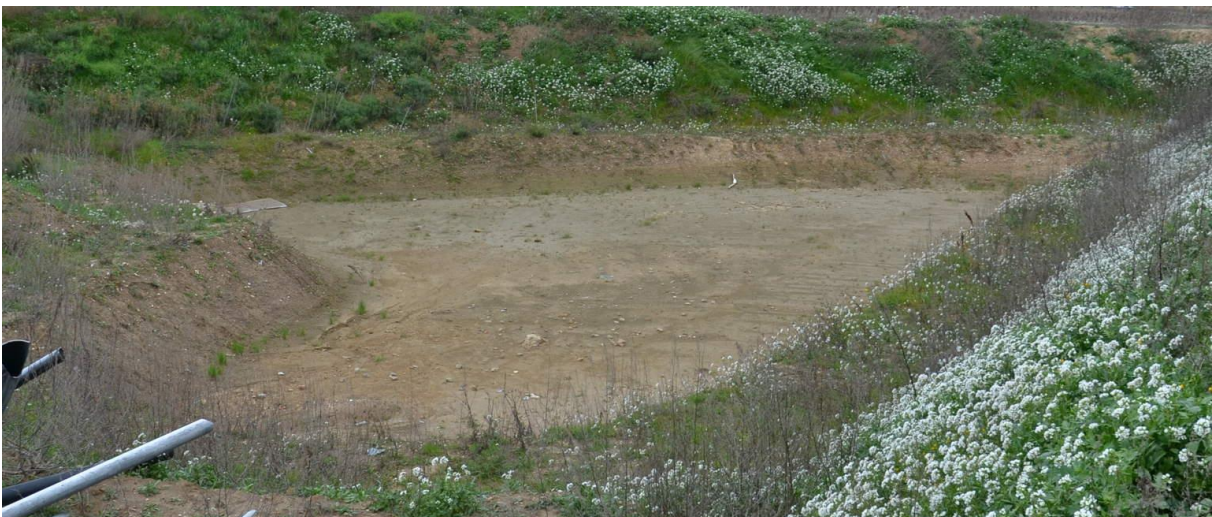
☞ Photographie : Réserve d'eau en cas d'incendie (à sec en conditions normales)
